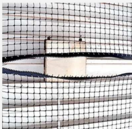
1. ábra: Hálózott terület mögött hozzáférés biztosítása cipzár segítségével
